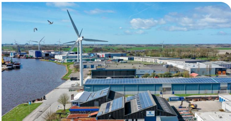
Elektrificatie bedrijven en industrie
